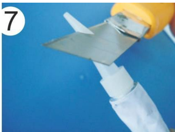
Schneiden Sie den Auslasstrichter schräg an.
