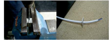
6. In Silikon-Endkappe Loch für Kabel erstellen und Endkappe auf Kabel schieben
