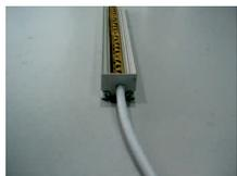
7. Abdeckung einsetzen. Falls erforderlich Abdeckung mit Kleber festkleben
